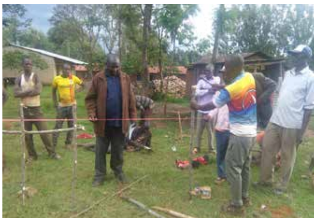
De aannemer met zijn ploeg aan het werk
